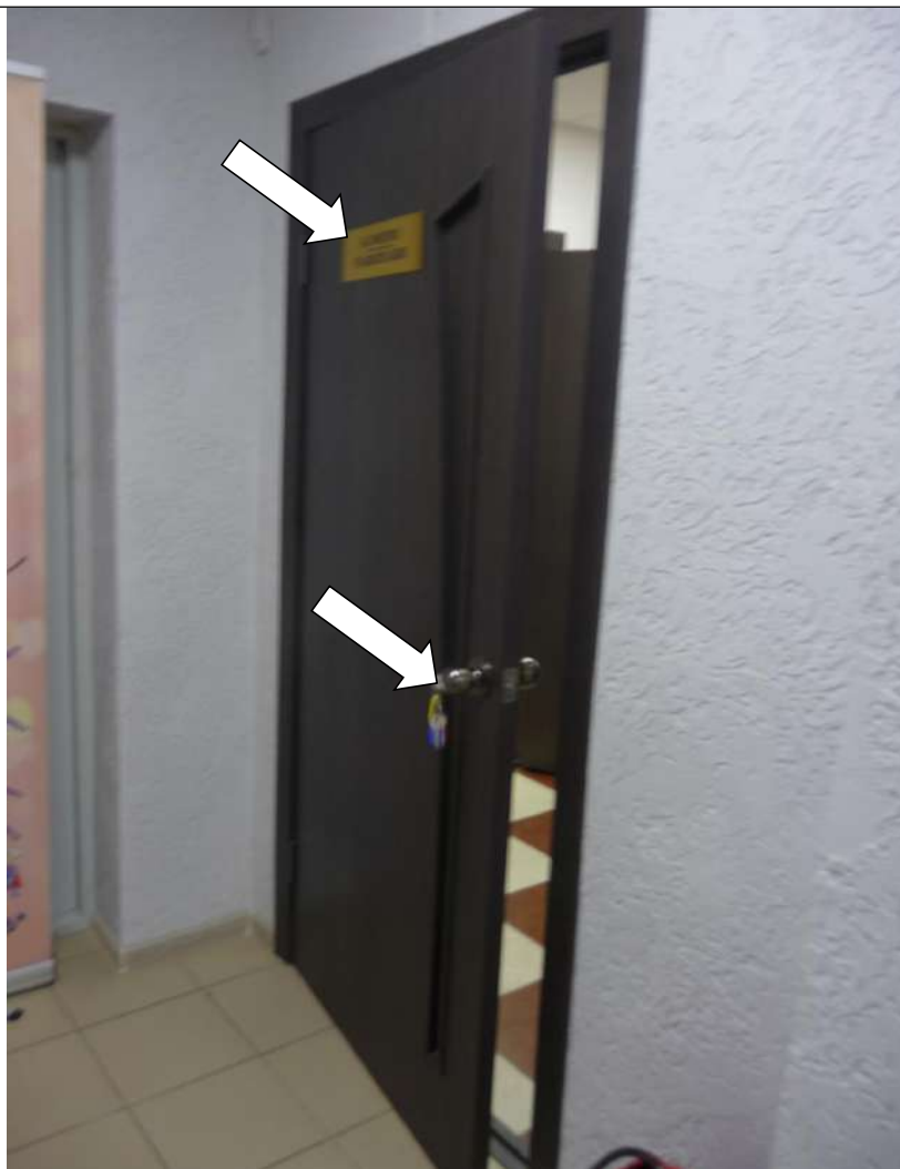
Фото № 9. Дверная ручка круглая. Информационная табличка расположена на дверном полотне, нетактильная.
