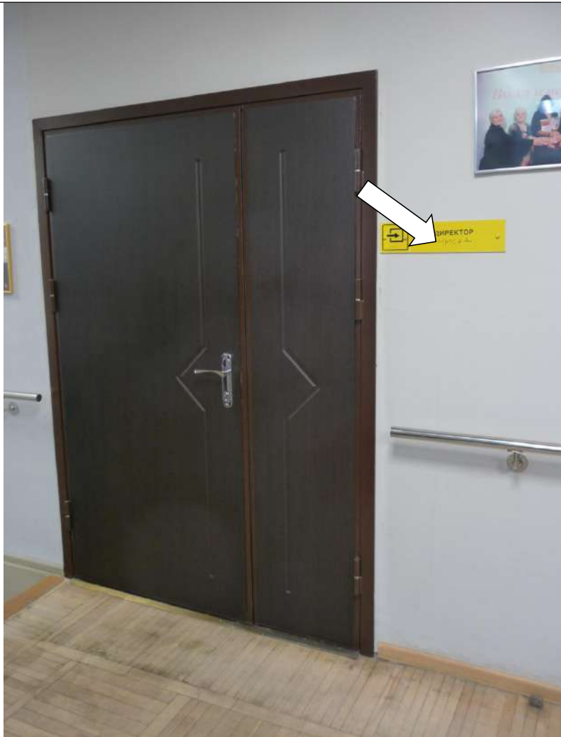
Фото № 7. Тактильный шрифт и шрифт Брайля на информационной табличке не соответствует требованиям нормативной документации.
